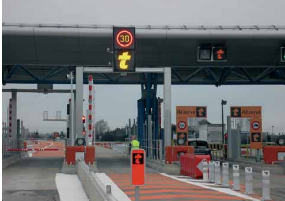
télépéage sans arrêt sur A54 (photo ASF).
