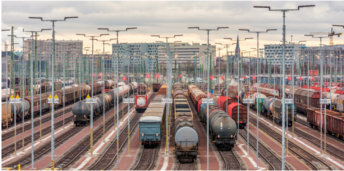
Gare de Halle-sur-Saale, Allemagne
